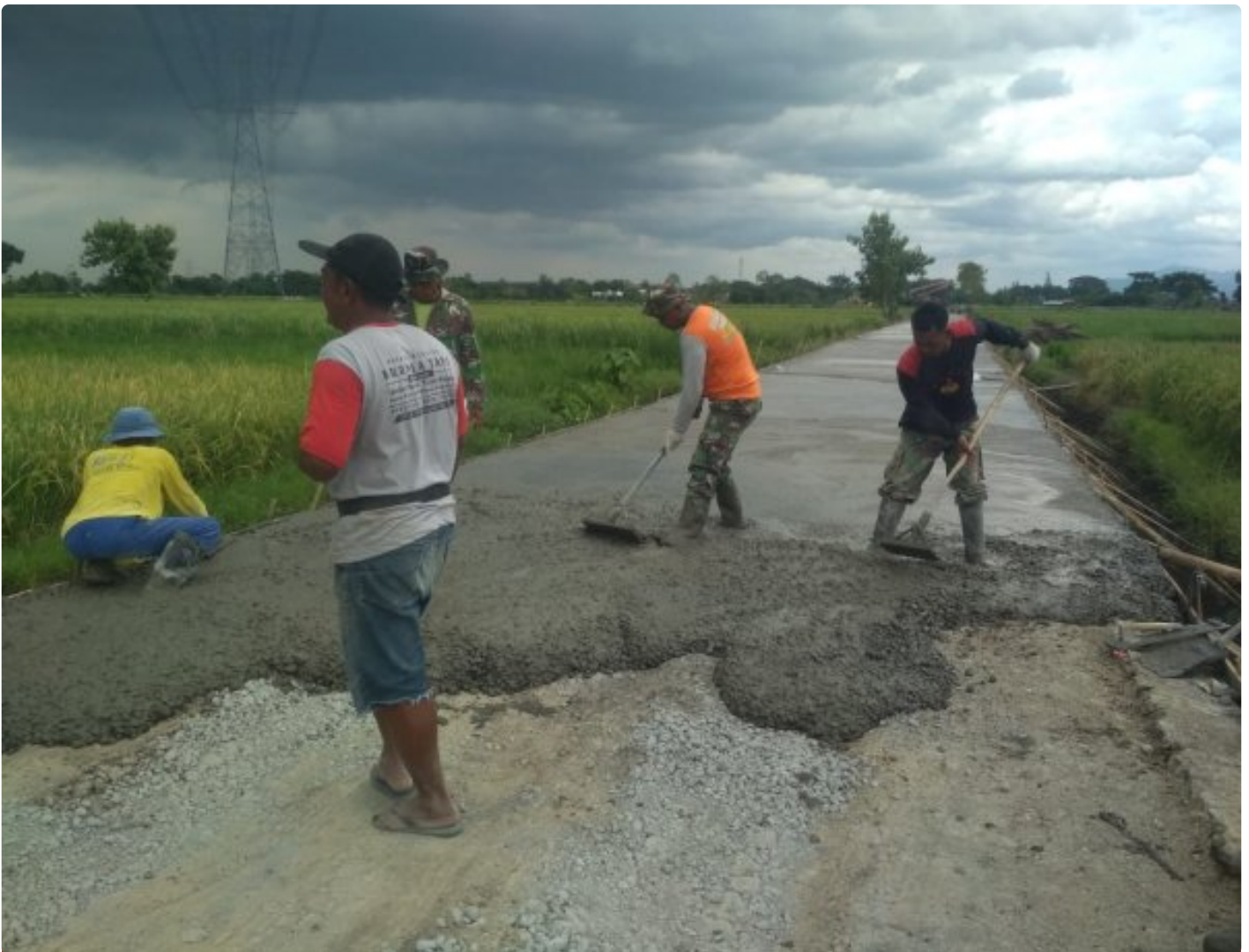
Puasa Bukan Halangan Bagi Satgas TMMD Kodim 0723 Klaten
